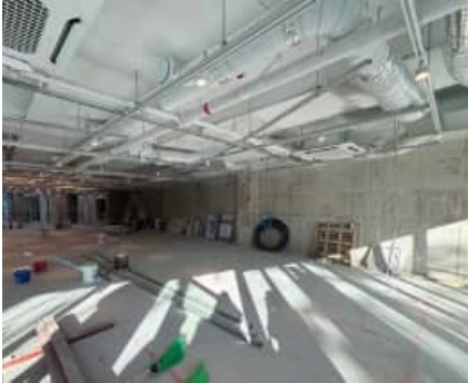
공사중인 복지관 1층 로비
